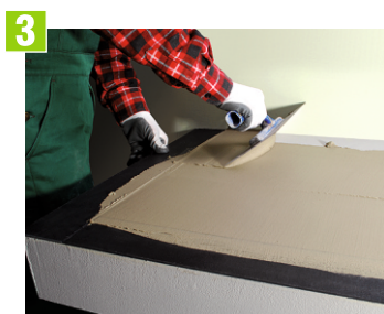
Nanášanie malty do kompenzačnej výšky šablóny
