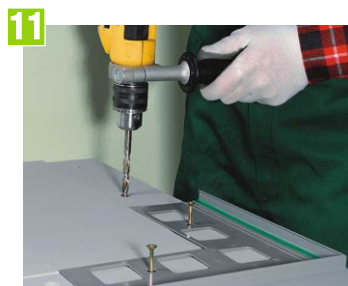
Vyvrátame otvory, do ktorých vložíme hmoždinky
