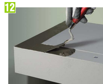
Nanesieme hydroizoláciu a inštalujeme profily
