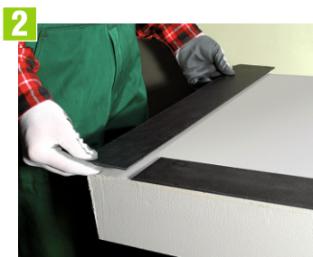
Uloženie montážnej šablóny pozdĺž okrajov balkónu
