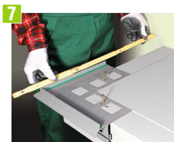
Začíname montážou rohových prvkov. Medzi profilmi necháme 2mm širokú dilatačnú škáru
