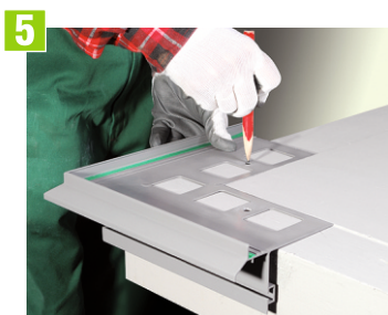
Označíme otvory pre montáž rohových prvkov
